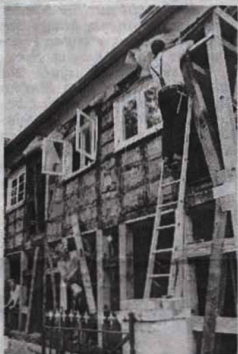
Zur Zeit wird das alte Fachwerk der Außenwand aufgemöbelt.
